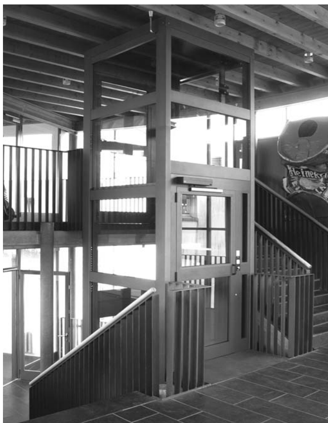
Sonderaufzug Högg E50 mit selbsttragendem, verglasten Metallschacht
