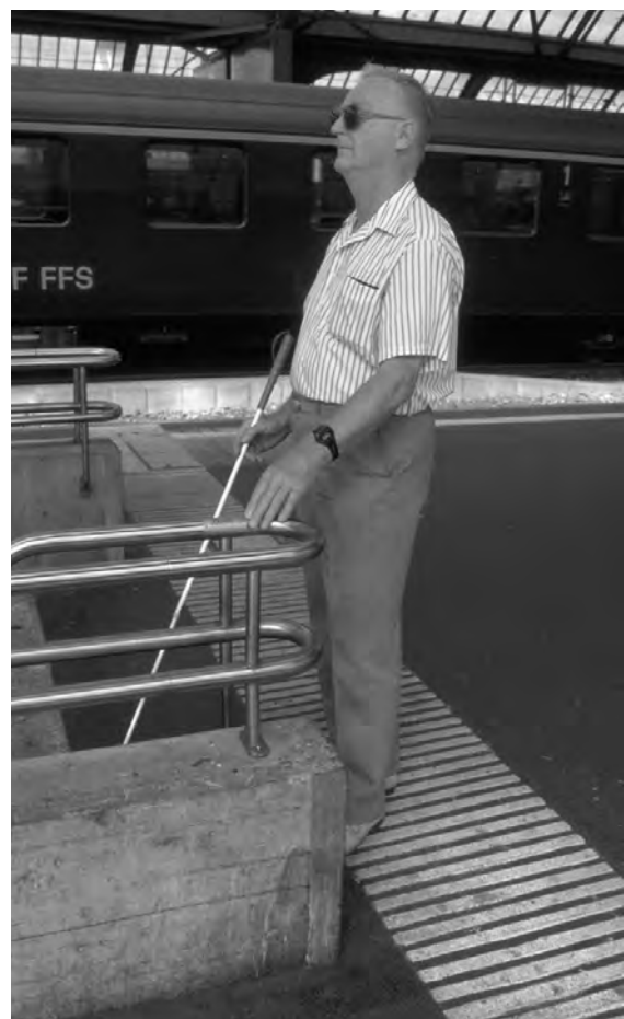
Ein Aufmerksamkeitsfeld über die ganze Breite des Perron zeigt den Treppenabgang an
